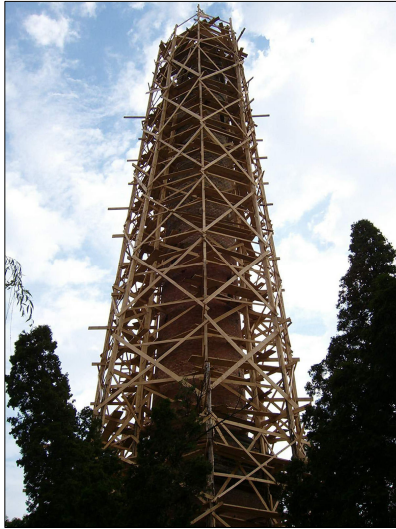
A felújítás alatt álló Tűzoltótorony
